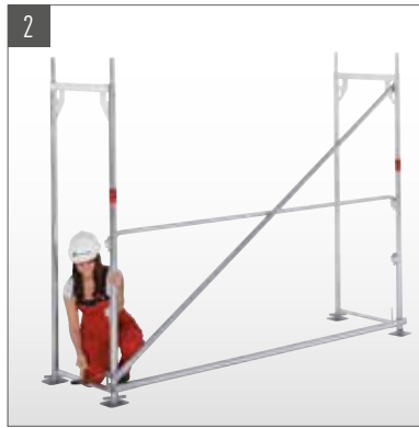
2 Vertikaldiagonale montieren, Horizontalstrebe einbauen (nur im Diagonalfeld).
