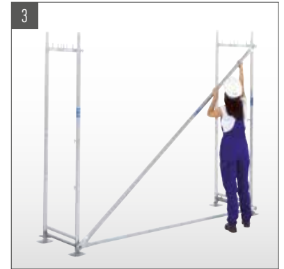
3 Diagonale über Kippstifte montieren.
